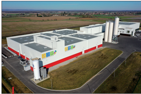
Le site SGR à Chalon-sur-Saône (Saône-et-Loire) a été inauguré en 2019.
