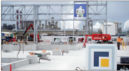
La construction de l'usine Resicare a démarré à Roussillon dans le Vaucluse.
