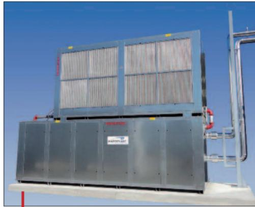
La conception modulaire des SIREG permet de faire fonctionner en parallèle plusieurs machines pour augmenter la puissance d'une installation (sans limitation du nombre de machines sur un même circuit).
