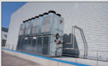
(pouvant travailler en free cooling) Industrial Frigo, installée par la société yonnaxienne Martiplast. Avec une température de consigne de 15°C, elle a pu fonctionner en free cooling un peu plus de la moitié de l'année, ce qui représente une importante réduction des coûts en énergie. Cette machine est équipée de ventilateurs brushless avec cheminées Axitop permettant de réduire le niveau de bruit en fonctionnement à seulement 68dB à 10 m.
