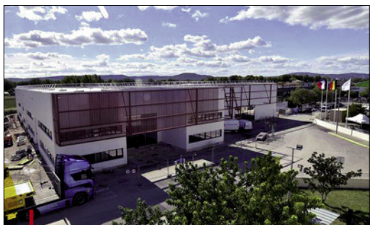
Le nouveau bâtiment va doubler la capacité de fabrication du site de Pertuis.
