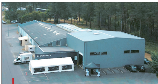
L'usine de Soustons sera prochainement agrandie.
