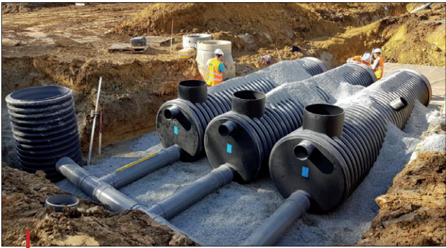
Fabriquée sur mesure à partir de tubes ou de drains annelés SN8, la solution Tamp'Eau autorise la réalisation de bassins de rétention, de tamponnement d'orage ou d'infiltration.
