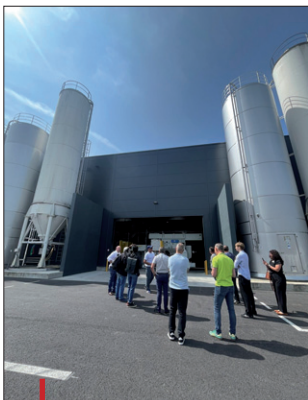
Le stockage et l'alimentation des matières sont automatisés.
