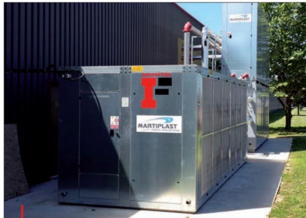
L'installation Industrial Frigo mise en place à Vernon par Martiplast. Au deuxième plan, le système SIREG composé de deux caissons préfabriqués superposés livrés prêts à brancher.
