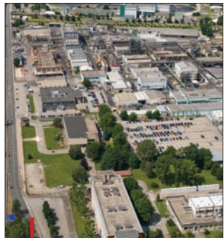
Les installations de Bluestar dans la vallée de la chimie au sud de Lyon.
