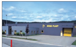
Sermi-Plast quittera ses locaux actuels pour s'installer chez PRP.
