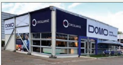
Domo est partenaire de la plateforme blockchain Circularise assurant la traçabilité des contenus des polymères.
